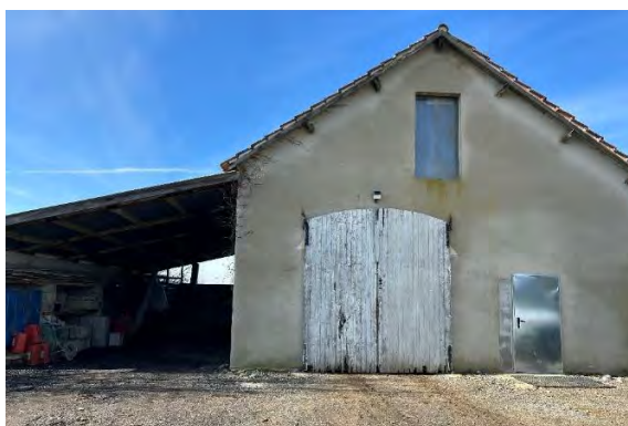
Figure 13 - Photo du bâtiment susceptible de changer de destination
