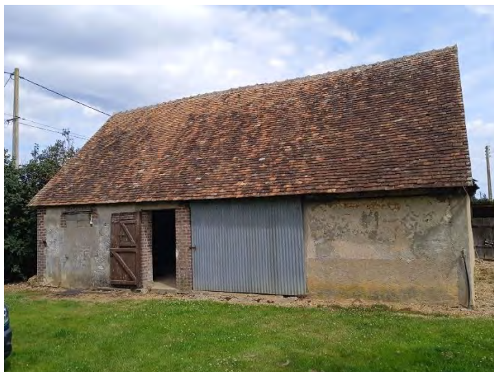
Figure 18 - Photo du bâtiment susceptible de changer de destination
