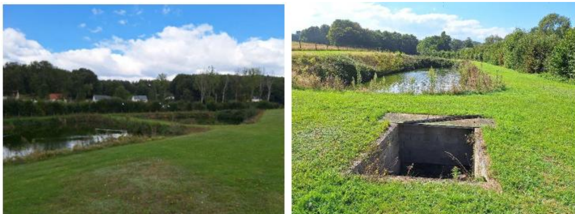
Figure 5 - La station d'épuration actuelle (Artelia)
