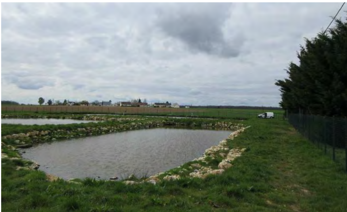
Figure 26 - L'actuelle station d'épuration
