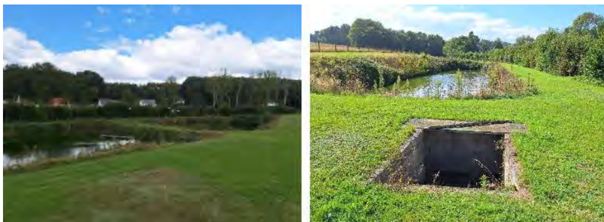
Figure 8 - Station d'épuration actuelle de Crotelles (Mémoire explicatif de l'AVP dans le cadre de la réhabilitation du réseau d'assainissement – Artelia, novembre 2024)
