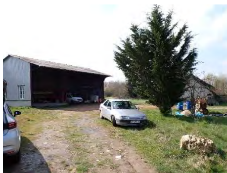
Bâti (secteur n°6)
