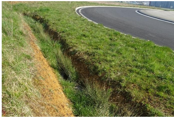
Photo 1 : Partie en eau du fossé (in situ, IEA)
