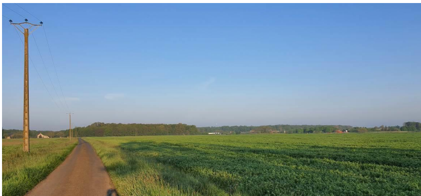
Le site du projet (à droite), vu depuis le chemin communal n°12 (ici à gauche).
