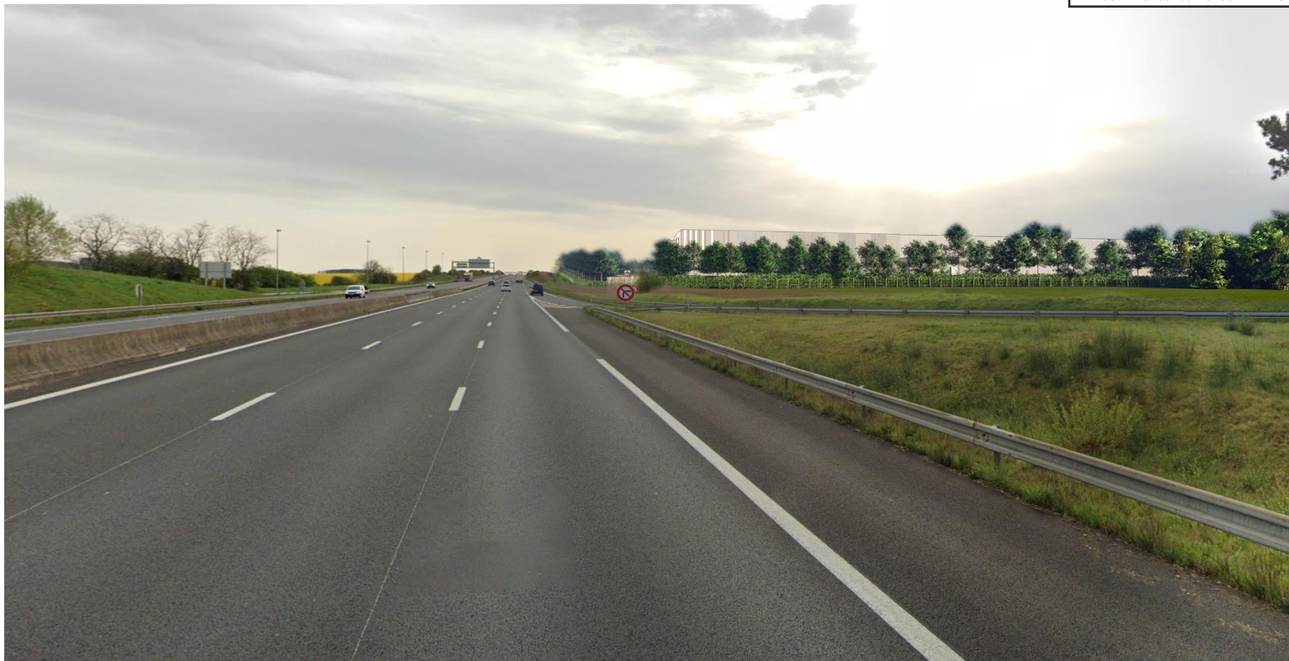
Insertion Ouest : Autoroute A10 en direction de Blois. DNS
