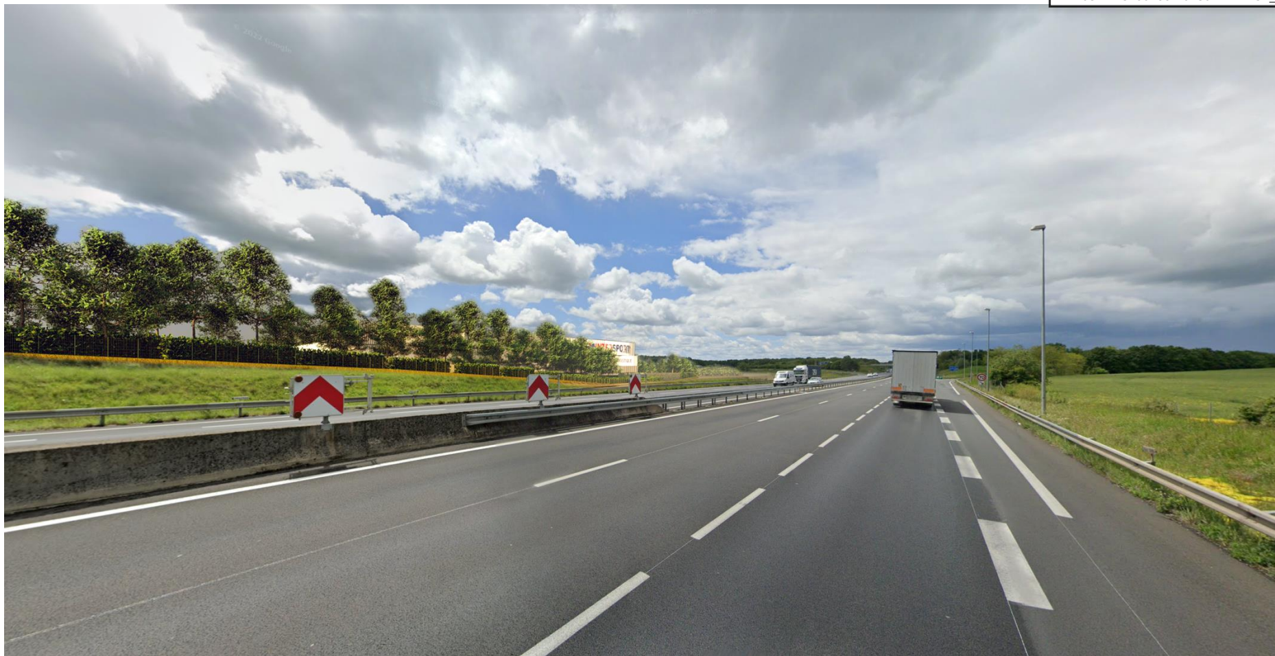
Insertion Est : Autoroute A10 en direction de Tours.
