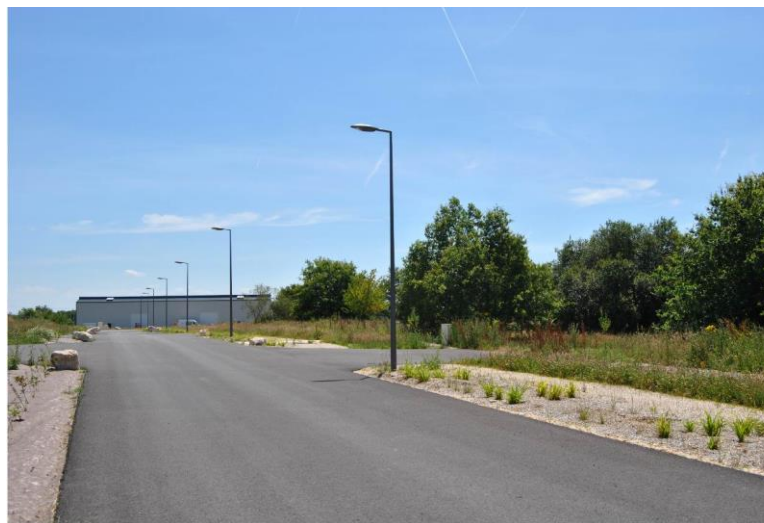
Le parc Porte de Touraine en cours d'aménagement : un site en pleine mutation
