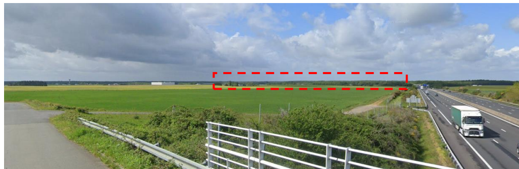
Vue sur le site d'extension de la ZAC (cadre rouge) depuis l'ouvrage franchissant l'A 10 au sud du bourg de Morand (panorama vers le sud-ouest). A gauche le bourg d'Autrèche et son château d'eau. Source : Google Earth Street View.
