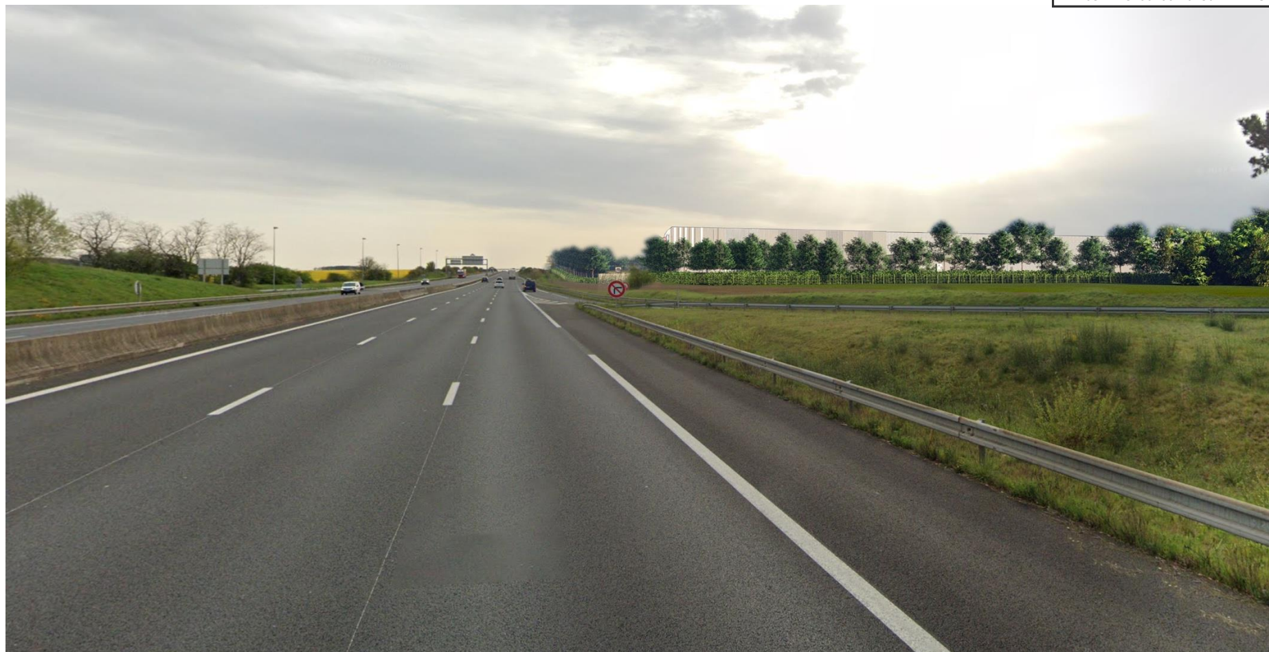
1 Insertion Ouest : Autoroute A10 en direction de Blois. DNS
