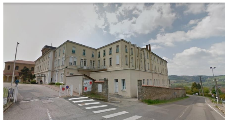
Centre médical de l'Argentière
