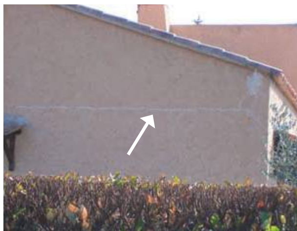
Fissuration traduisant un décollement de la structure par absence de liaisonnement entre niveau bas et comble.
