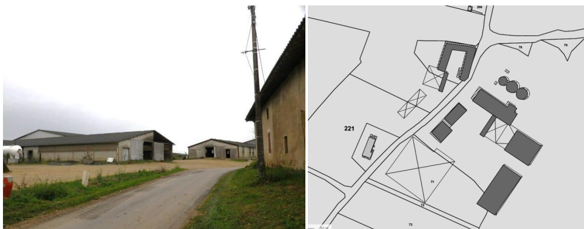
Bâtiments agricoles à Sermoyer
