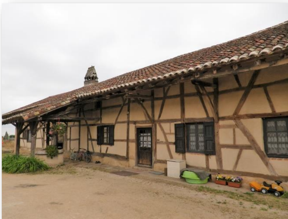
La ferme du Mont et sa cheminée sarrasine à Chevroux, classée le 9 juillet 1980
