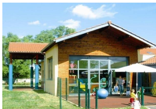
Pôle petite enfance intercommunal à Replonges
