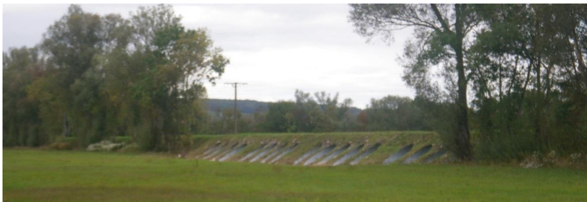
Ouvrages hydrauliques permettant le passage de la faune au niveau de la D1 dans le Val de Saône
