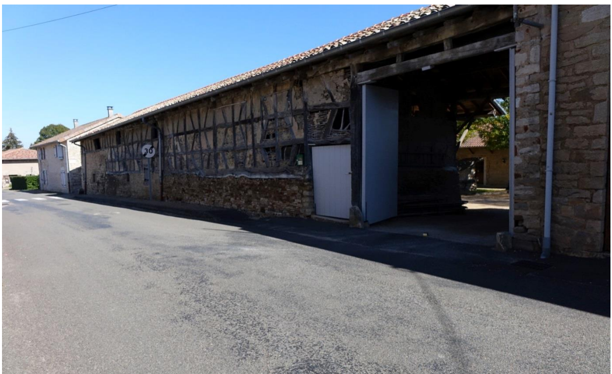
Une « rue de façades », particulièrement longue à Reyssouze. – © Atelier du Triangle
