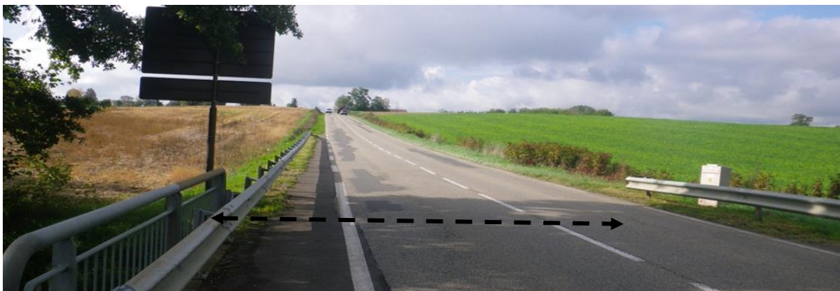
Corridor n°29 entre Saint-Bénigne et Arbigny
