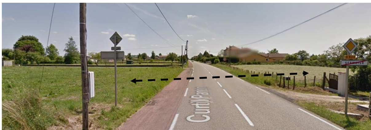
Corridor n°33 à Sermoyer (photo : Streetview aout 2013)
