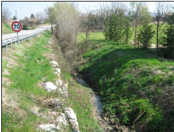
Figure 3-13 : Zone amont du Bouchalas avec un enrochement rive gauche
