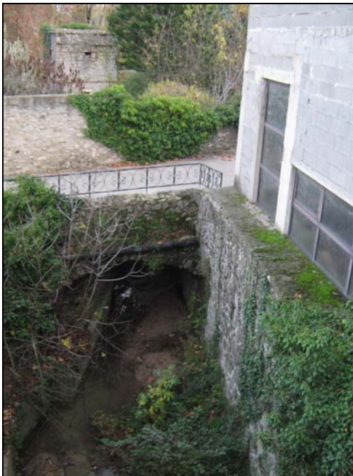
Figure 3-18 : Le Pied de Baix en aval de la voie SNCF
