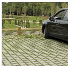
Pavé bétons avec joints engazonnés
