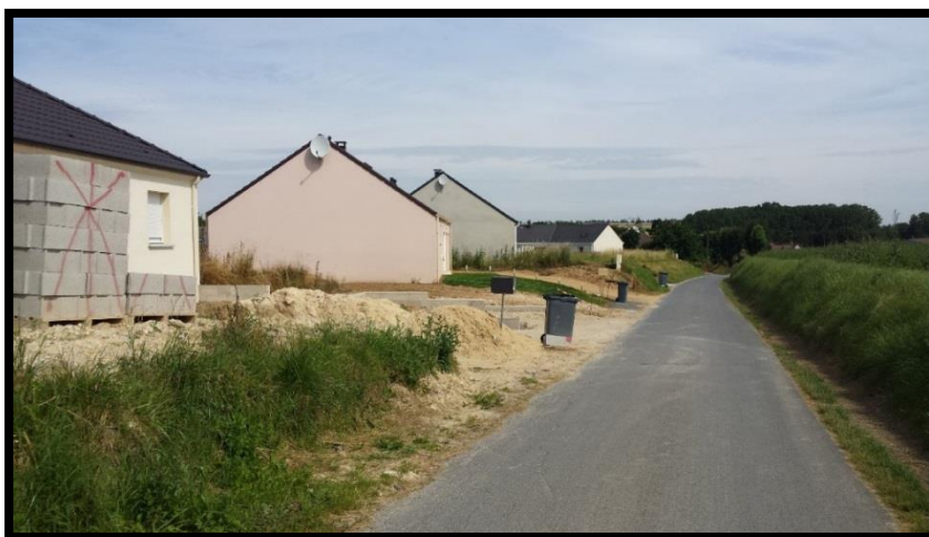
Lotissement récent à Saint Loup-en-Champagne : route étroite, circulation des engins agricoles difficile.
