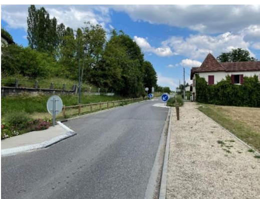
FIGURE 29 : ZONE 30 ET CHICANES SUR LA RD 656, COMMUNE DE POUDENAS
