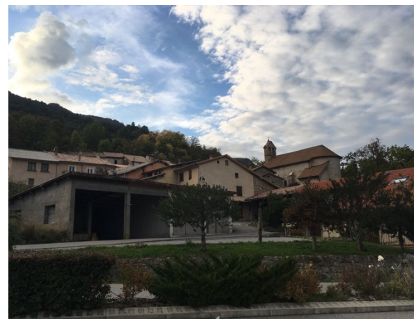
Vue sur le clocher de l'église
