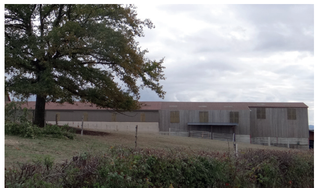
Bon exemple d'extension de ferme qui s'intègre dans le paysage. Les teintes des revêtements sont adaptés à leur environnement. La volumétrie et les ouvertures sont cohérentes et simples
