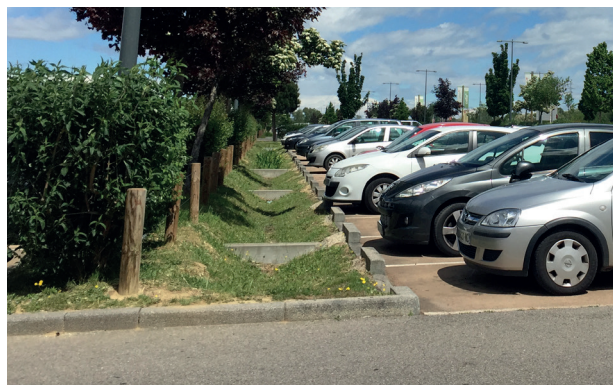
Places de stationnement d'une zone commerciale en stabilisé infiltrant, bordures «crênelées» pour laisser passer l'eau guidée par la pente, noue drainante végétalisée
