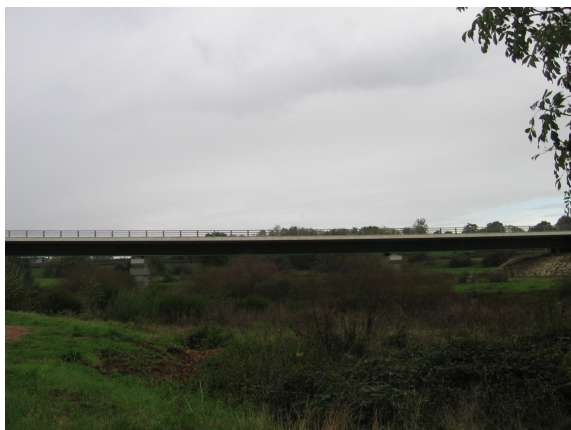
3- Nouvel ouvrage sur la Bourbince
