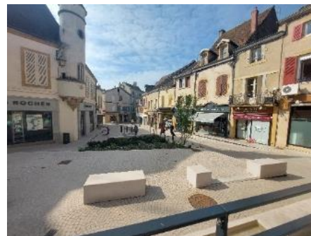
Des aménagements et rénovations récents
