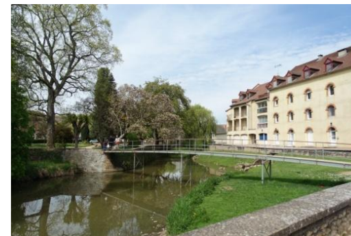
Passerelle à Charolles
