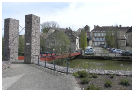
Passerelle à Charolles
