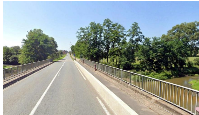
RD 994 – Entrée majeure à l'ouest de Digoïn
