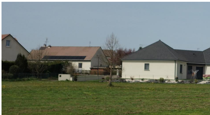
Photovoltaïque en toiture – Paray-le-Monial
