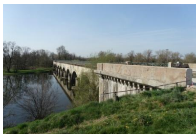
Le Pont Canal // Digoïn
