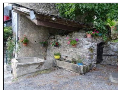
6 Lavoir et puit
