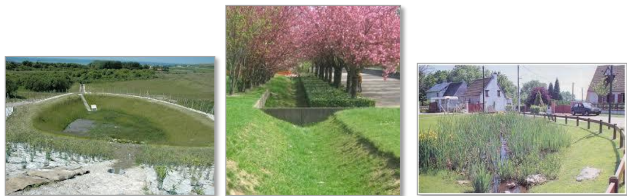
Illustration 15 : Bassin de rétention (à gauche), Fossé tampon (au centre), Noue paysagère (à droite)
