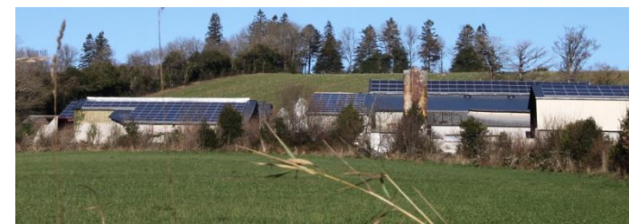
Panneaux photovoltaïques sur hangars agricoles, Moulin-Mage Source : Artifex
