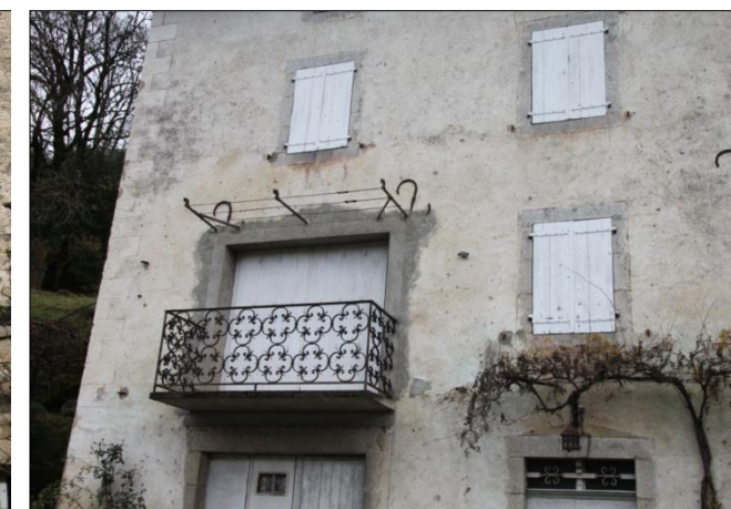
Balcon en fer forgé et treille à vigne sur l'entrée, Espérausses
