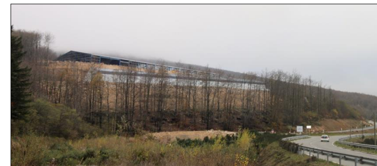
Usine d'embouteillage de Lacaune Source : Artifex
