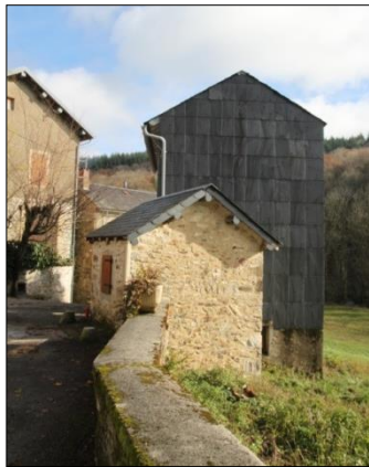
Essentage d'ardoises, pierres jointoyées d'enduits à la chaux et au sable, à Nages Source : Artifex
