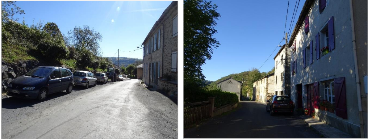
Illustration 30 : Espace de stationnement non matérialisé à Senaux (à gauche) et à Escroux (à droite) – Photo : URBA2D
