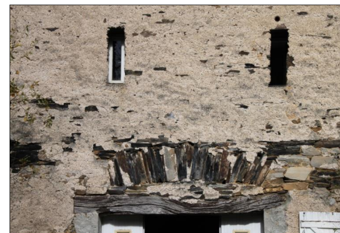
Arc de décharge au-dessus du linteau, percements de façade étroits, Viane
