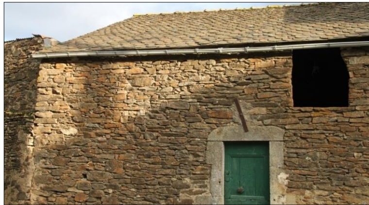
Grange au hameau de Montégut à Murat-sur-Vèbre : murs probablement en micaschistes et encadrement en granit Source : Artifex
