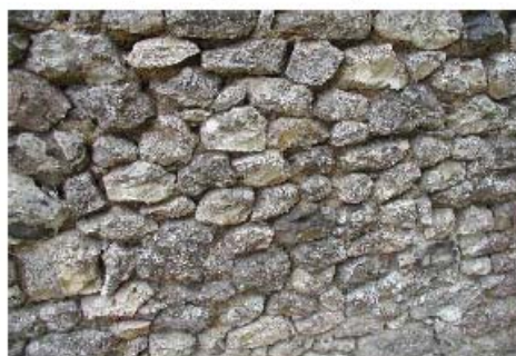
Détail d'un mur en pierre sèche
