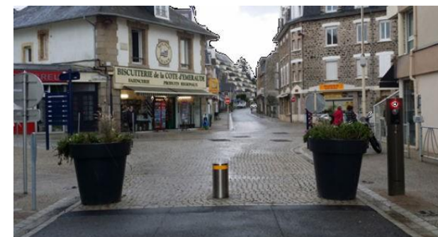
Exemple d'entrée d'axe piétonne avec borne escamotable et pots de fleurs
