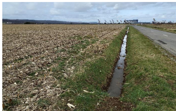
Berme routière avec fossé
