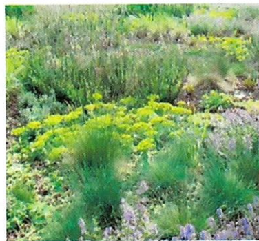
1. Toiture végétalisée semi-intensive
