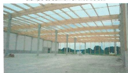
Exemple de bâtiment en structure bois partielle
