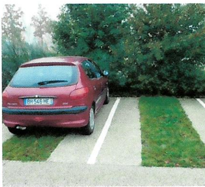
Surfaces semi-perméables stationnements
