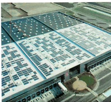
3 et 4. Intégration de panneaux photovoltaïques
