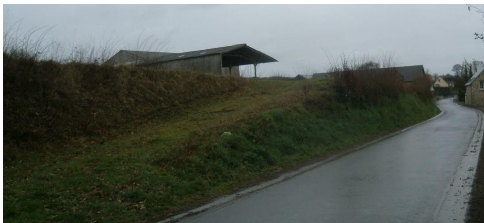
Vue sur la bordure Sud des parcelles 324 et 325, le long de la RD550 : talus assez haut ayant un effet drainant
