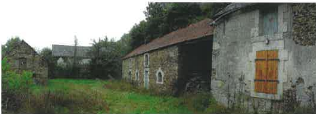
Logis et communs - Remise et ancienne cidrerie
