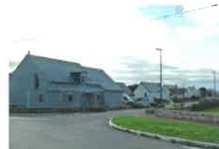
La toiture ardoise à 45°, un des rares caractères du bâti traditionnel repris dans l'habitat pavillonnaire
