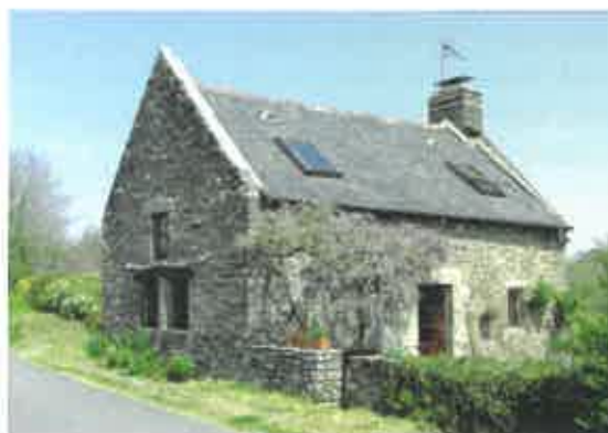
Ancien fournil devenu logement
