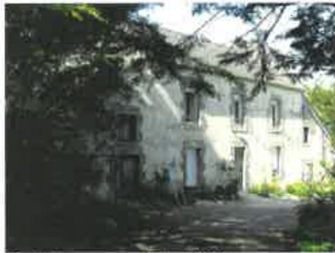
Rostel - nouveau logis 1900 avec appentis périphérique la rénovation est en cours.
