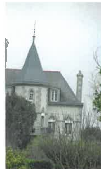
Bâtiment de caractère
