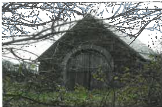
Grange du Pencleux
