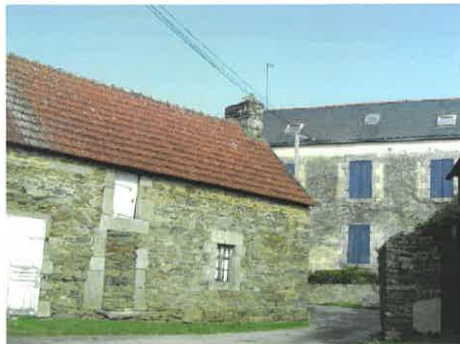
Utilisation complémentaire du schiste et du granite dans le bâti traditionnel (Keranquemat)
