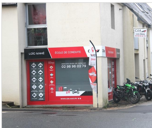
% de surface de façade non respecté
