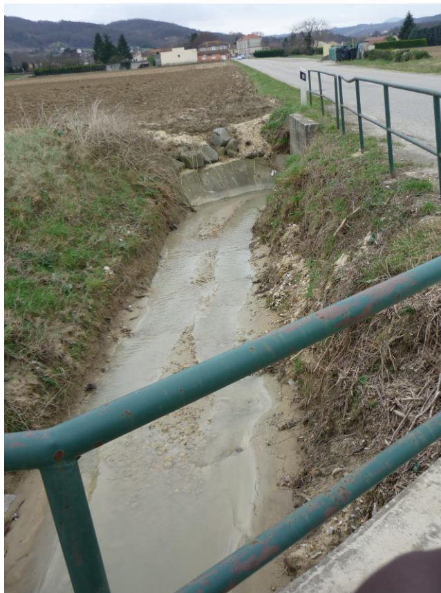
Ruisseau du Merdarioux au droit de la zone d'étude
