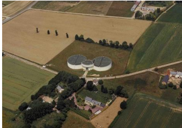
Photo site internet Eau du Bassin Rennais
