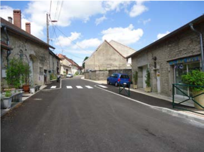
Aménagement rue de l’église à Onoz
