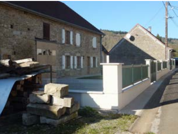
Nogna -Muret béton et barreaudage métal
