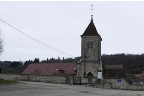
Rothonay : mur d'enceinte de l'Eglise
