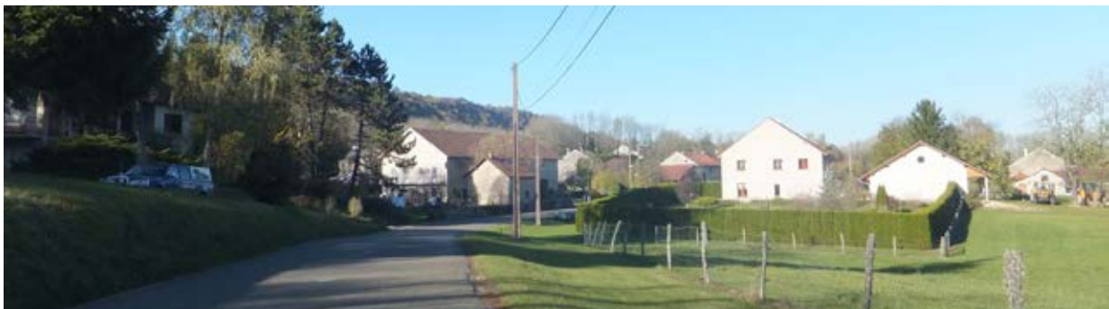
Arthenas, présente des façades orientées Nord/sud
