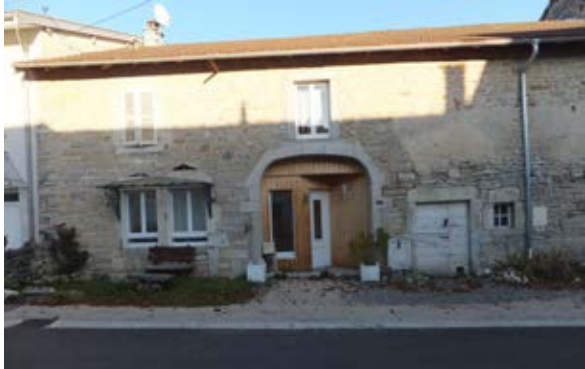
Onoz - pose d'élément de menuiserie préfabriqués
