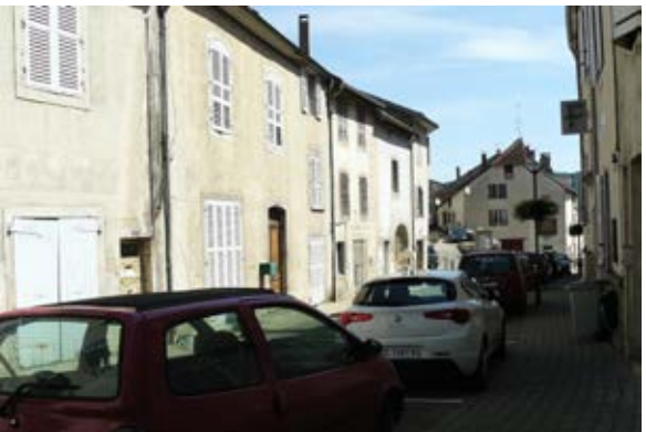
Alignement bâti à Orgelet
