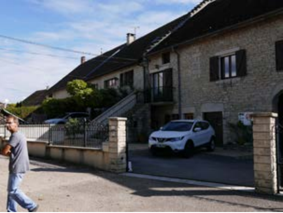
Nogna -Muret béton et barreaudage métal
