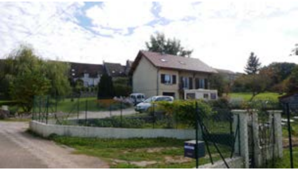
Construction d'une dent creuse à Saint-Maur
