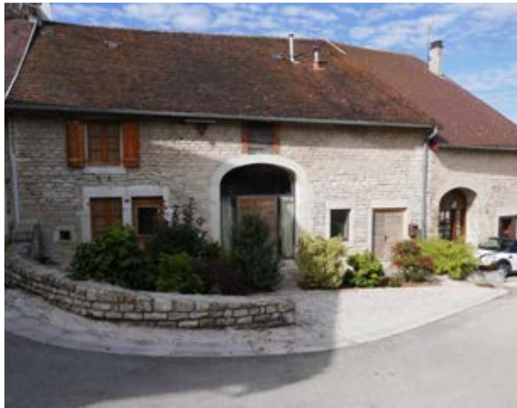
Saint-Maur - adaptation de la porte de Grange
