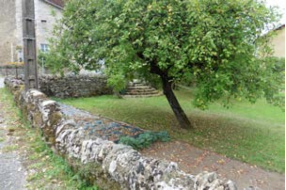
Mur en pierre à Cressia
