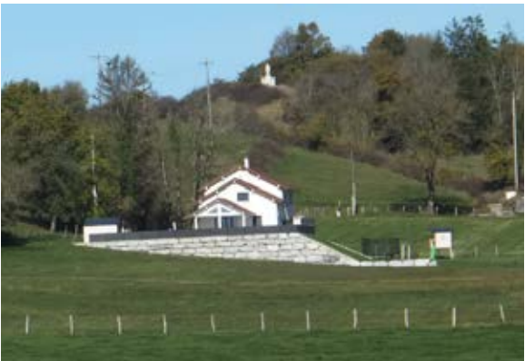
Rothonay : exemple de l’adaptation de la parcelle à l’habitat, création d’une plateforme
