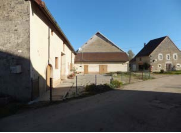
Poids-de-Fiole : muret en simple grillage
