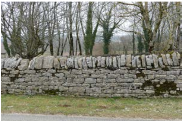
Poids-de-Fiole - muret de pierres sèches taillées à couronnement en pierre levées
