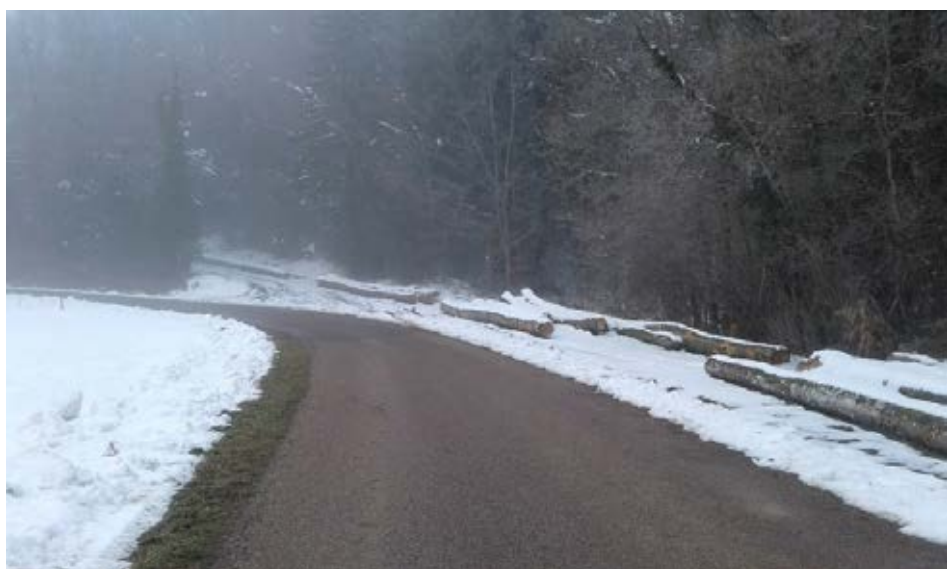
Route de Sarroigna à Chambéria et hameau de Nermier (Sarroigna) : faute d'aménagement spécifique pour le stockage à la jonction « piste forestière / route », le dépôt de bois est improvisé en bord de route. En plus des conflits que cela peut occasionner, le chargement des bois est rendu plus complexe et plus dangereux.
