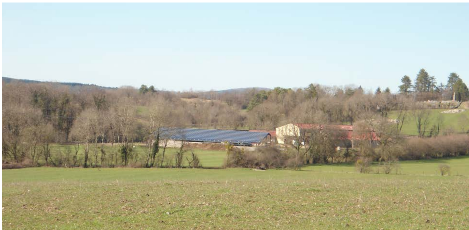
Toiture photovoltaïque sur bâtiment agricole à Sarroigna
