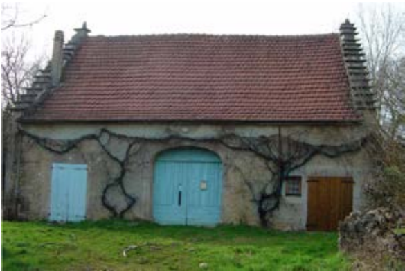
Ferme bloc à trois travées de volume simple (Alièze, photographie CAUE)
