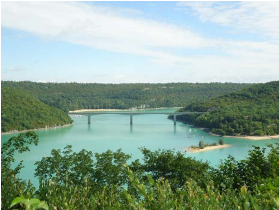
Le pont de la pyle
