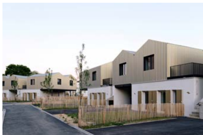
Habitat intermédiaire _ Fourchambault (58) Eco-cité la Garenne, 34 maisons, 2017
