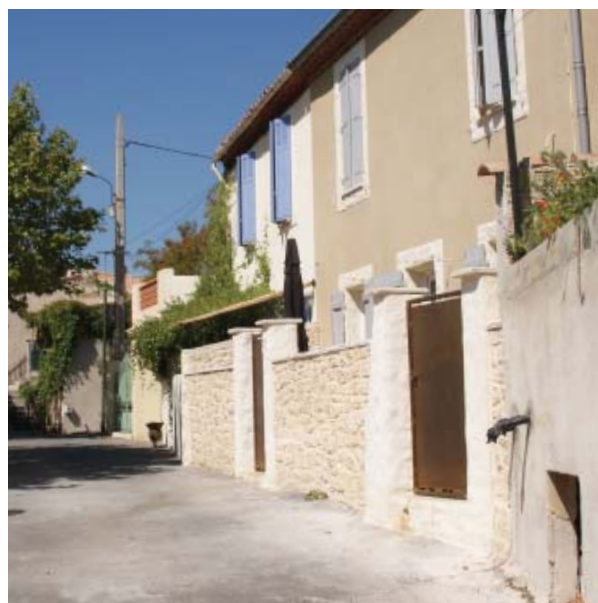
Mur de clôture plein, à pierres vues et gros joints à éviter.
