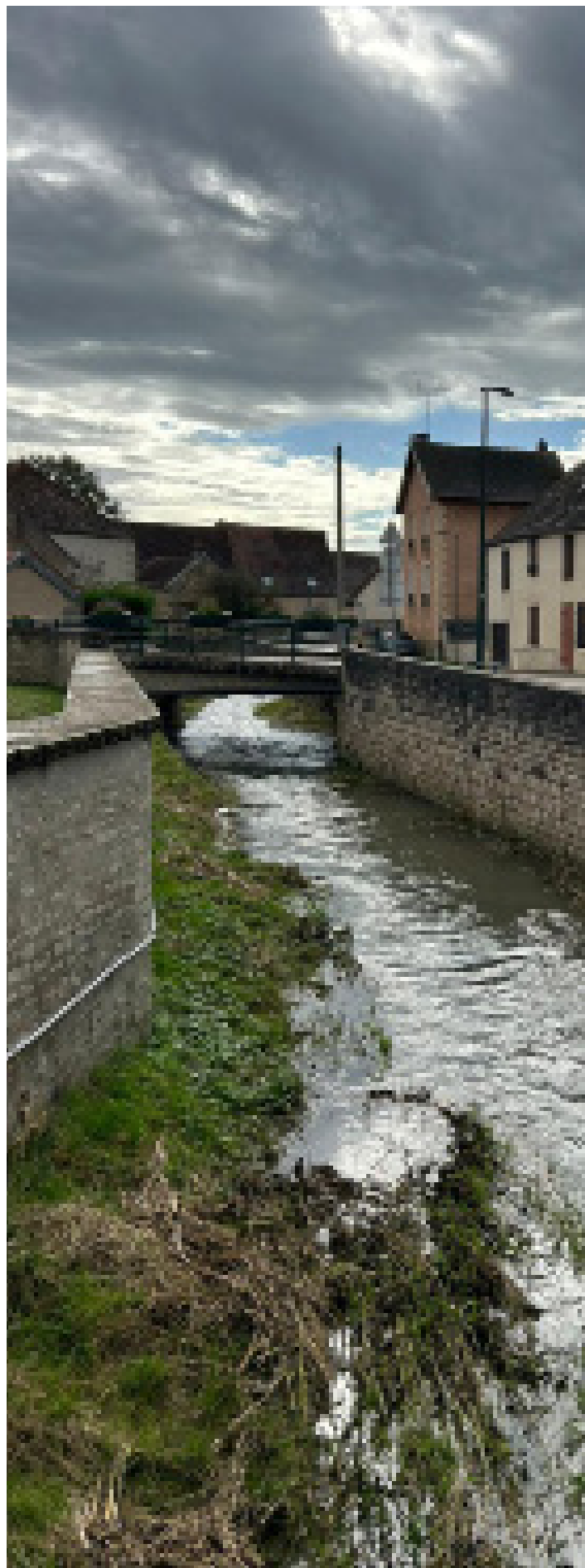
Cours d'eau de la Lochère dans le centre-bourg de Pouillenay
