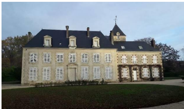
Photographie du bâtiment MAR03
