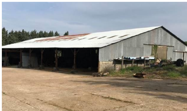
Photographie du bâtiment CON05
