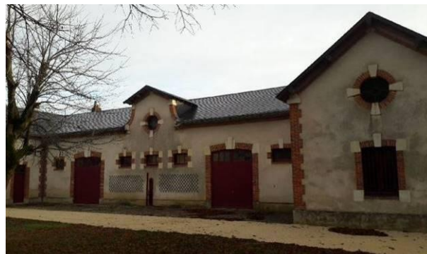
Photographie du bâtiment MAR04
