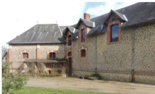
Photographie du bâtiment VIB05
