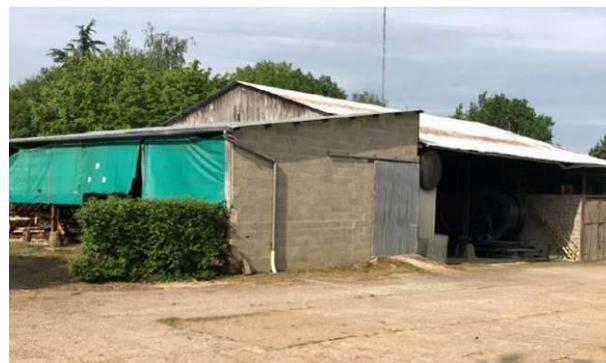
Photographie du bâtiment CON06
