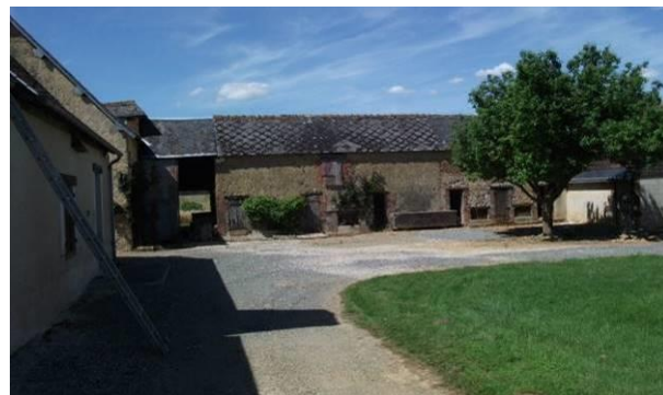
Photographie du bâtiment SAC31
