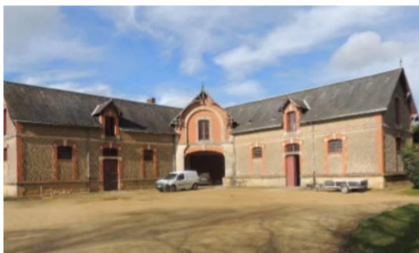
Photographie du bâtiment VIB04
