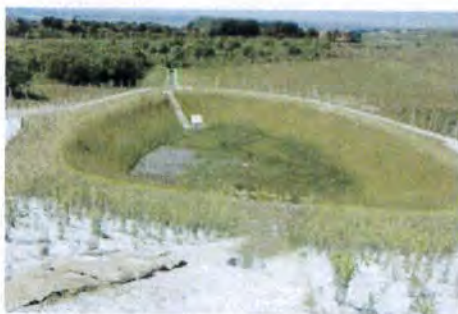
Bassin de rétention
