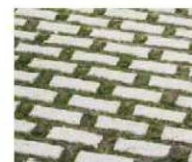
Pavage en béton avec ouvertures de drainage
