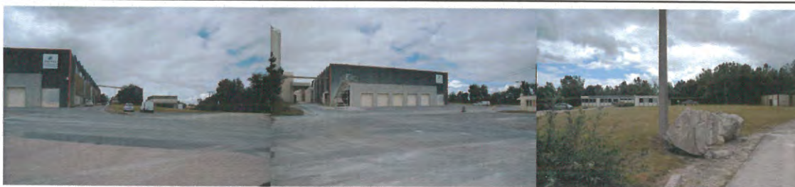
Vue des bâtiments présents sur le site
