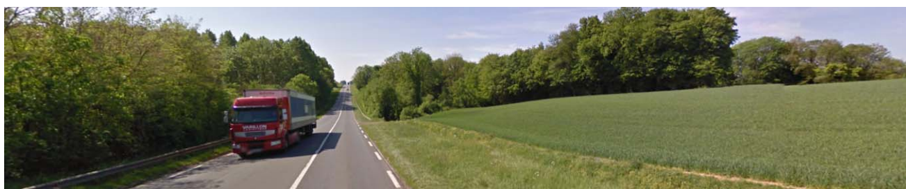
Le franchissement de la vallée du Pont
