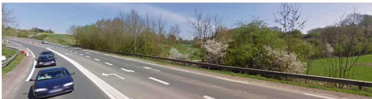
Le franchissement de la vallée de la Vicogne
