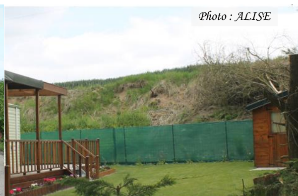
Photo n°4 Talus (Pont Noyelles)
