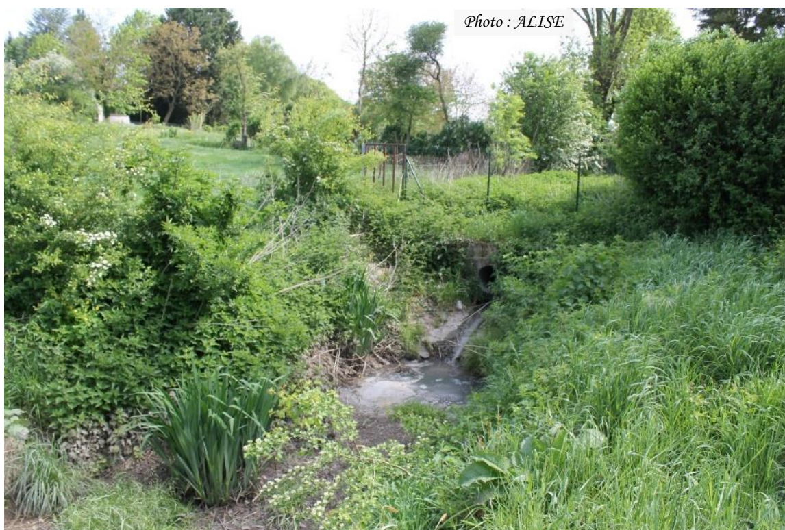
Photo n°15 Traces d'eaux blanches à l'exutoire du réseau d'eaux pluviales (Vaux-en-Amiénois)
