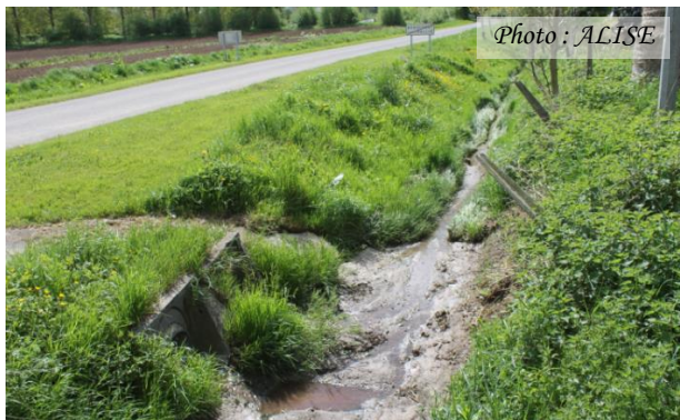
Photo n°7 Fossé (Beaucourt sur l'Hallue)
