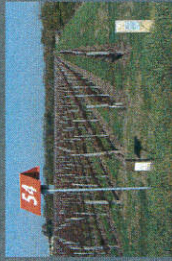
Différents types de bornes repérant les canalisations de transport
