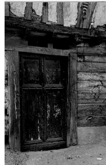
Vues prises en 1956 par A. Meury, photographe, médiathèque du patrimoine, d'une maison à pan de bois du XVII e siècle, conservant un rez-de-chaussée planchéié (aujourd'hui disparue ?)
