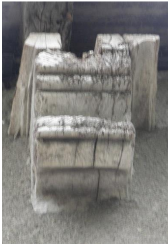
Vue de détail d'un about mouluré (maison p 158), vue de détail d'un about mouluré (p 64).
