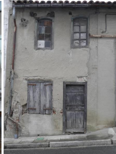
Maison Avenue des sports p 535
