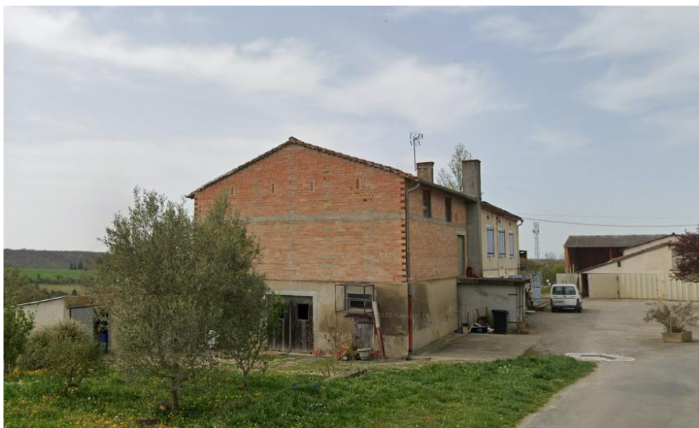
Photo du bâtiment (le premier) (Gool Street View)
