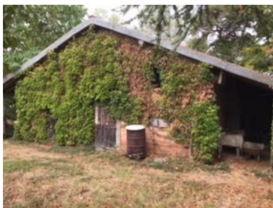
Photo du bâtiment (30/04/2024)
