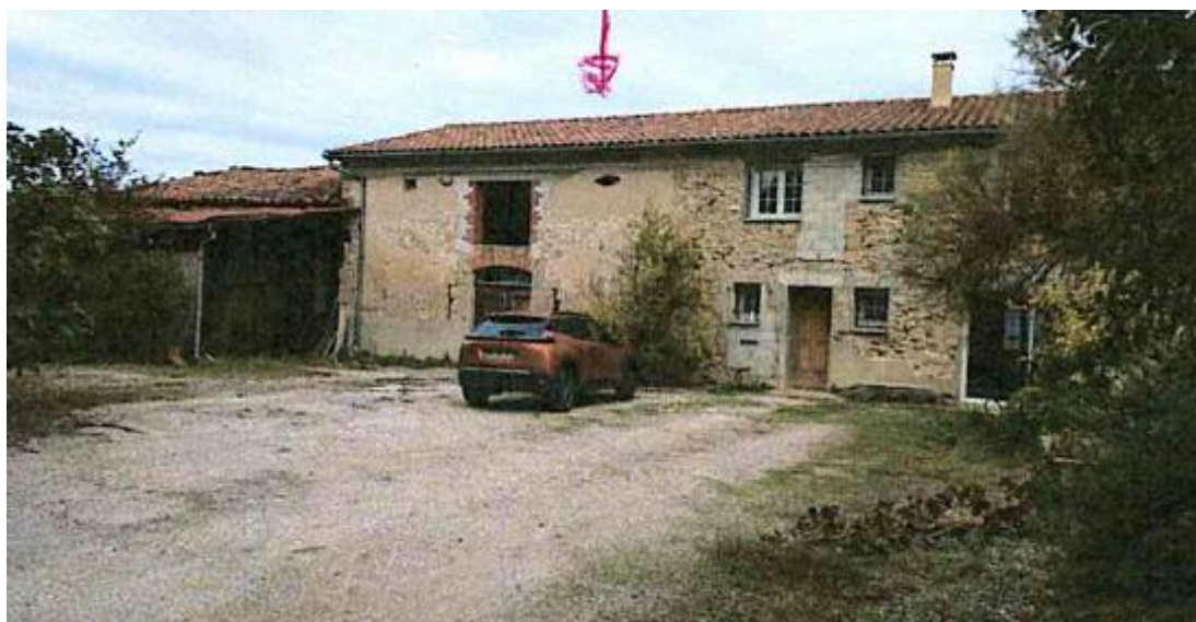
Photo du bâtiment (le 1/10/2024)
