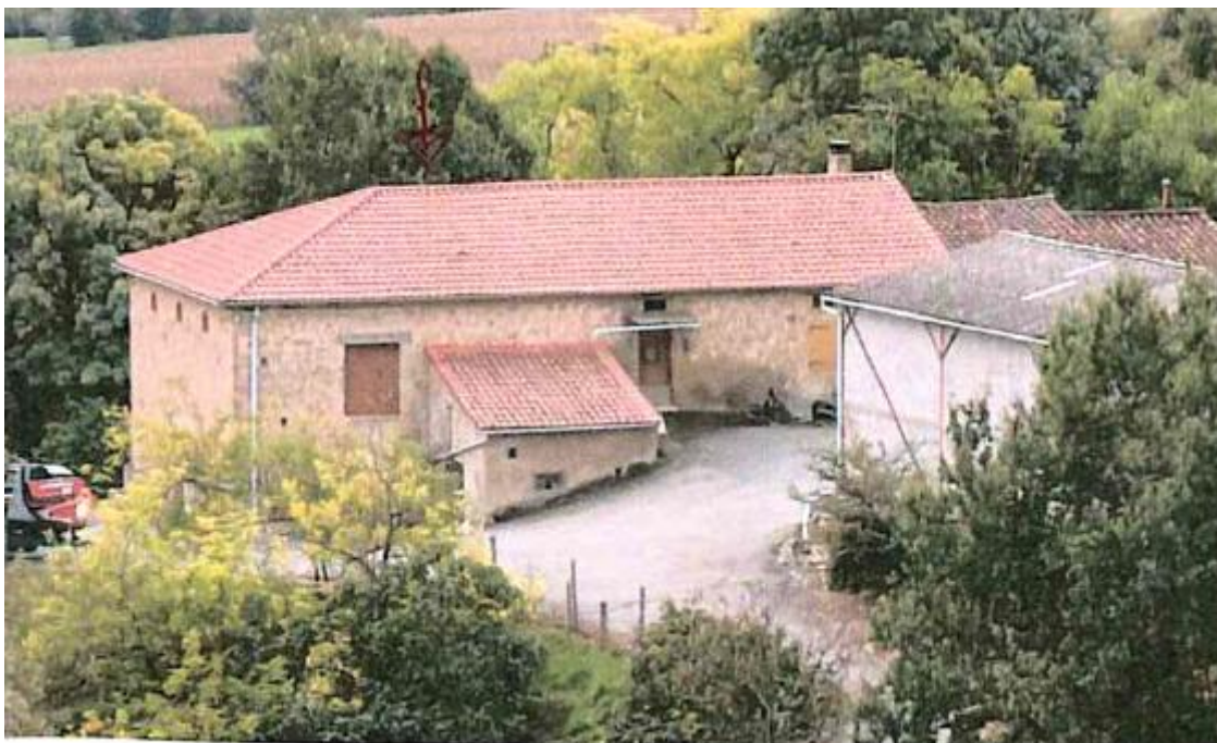
Photo du bâtiment (le 1/10/2024)
