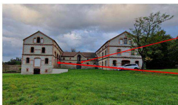
Vue générale façades sud vers Puylaurens
