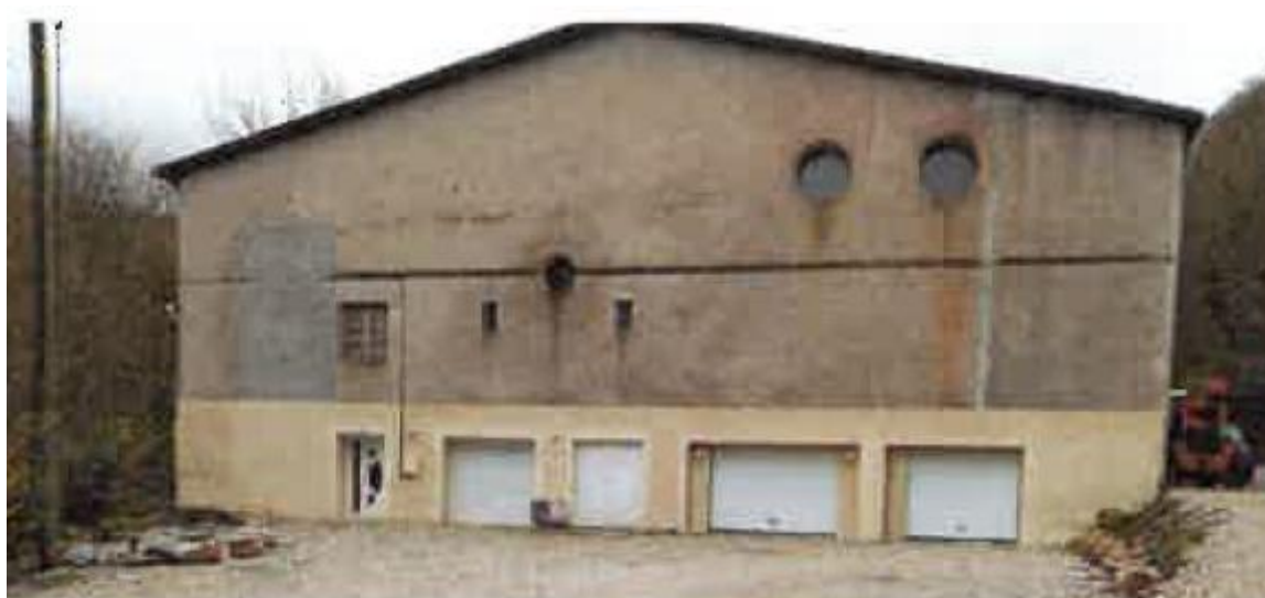
Photo du bâtiment (19/12/2024)
