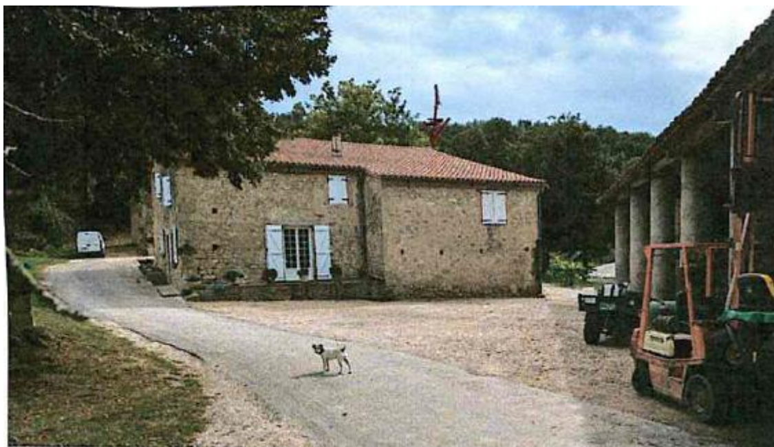
Photo du bâtiment (le 1/10/2024)
