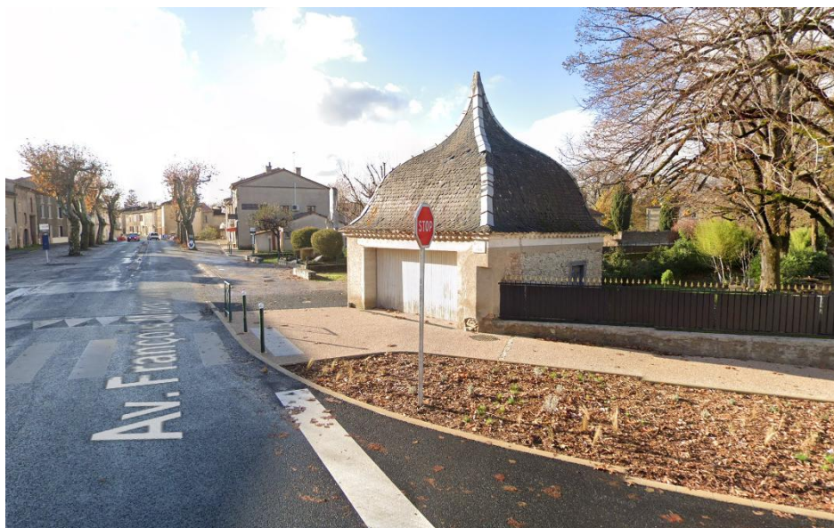
▲ Bâtiment concerné dans son état initial
