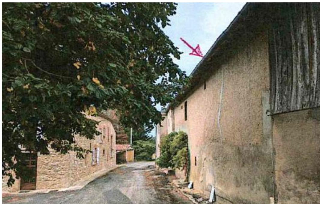
Photo du bâtiment (le 1/10/2024)
