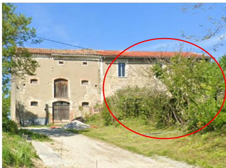
Photo du bâtiment (30/04/2024)
