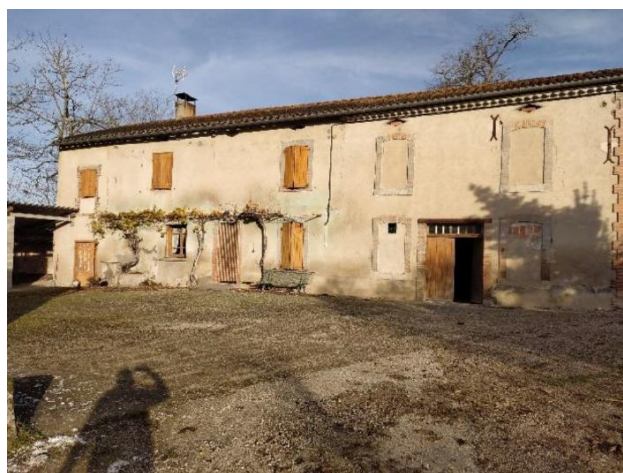
Photo du bâtiment à identifier (17 décembre 2024)
