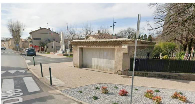
▲ Bâtiment concerné dans son état actuel
