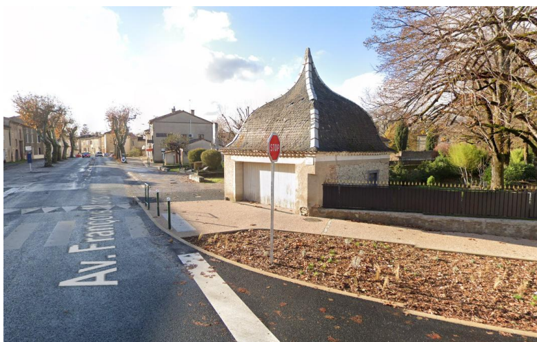
▲ Bâtiment concerné dans son état initial
