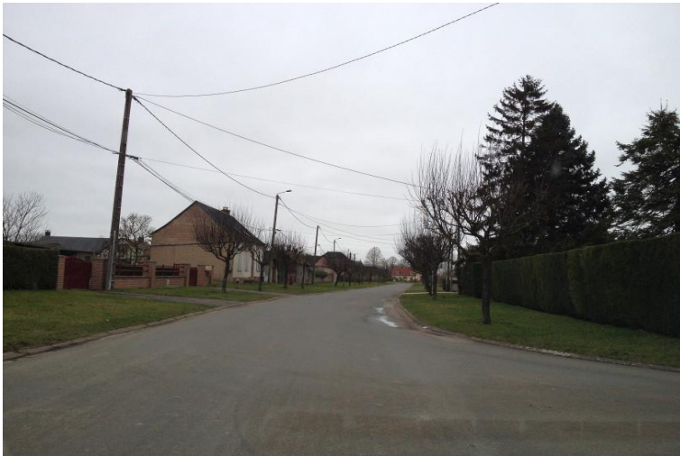
Trottoirs enherbés et bordures
