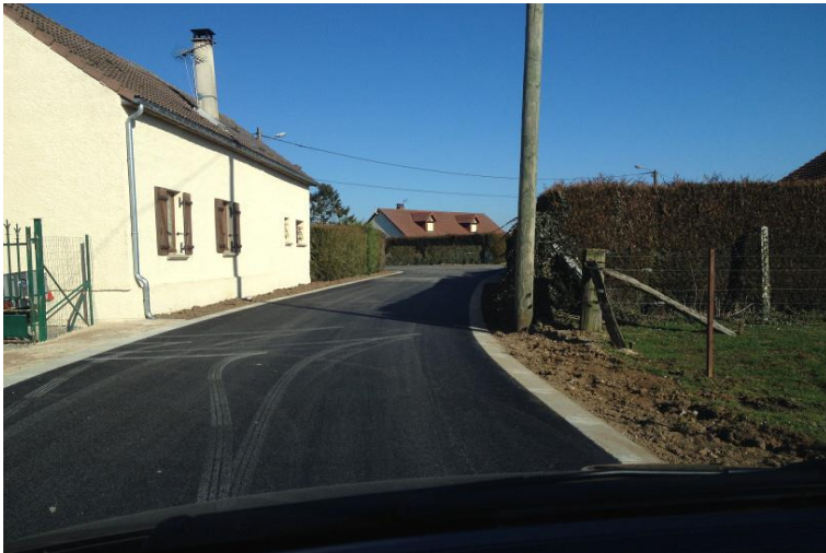
Rue refaite sans bordures
