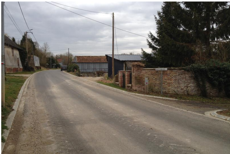
Trottoirs enherbés et bordures
