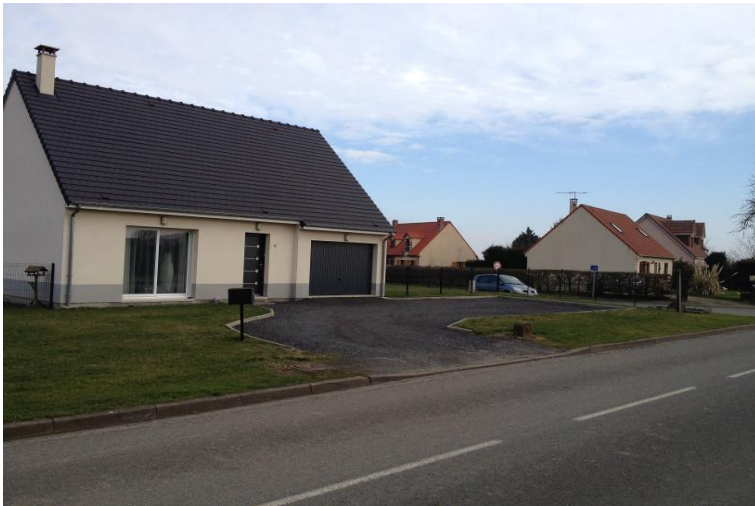
Accès à une parcelle non imperméabilisé
