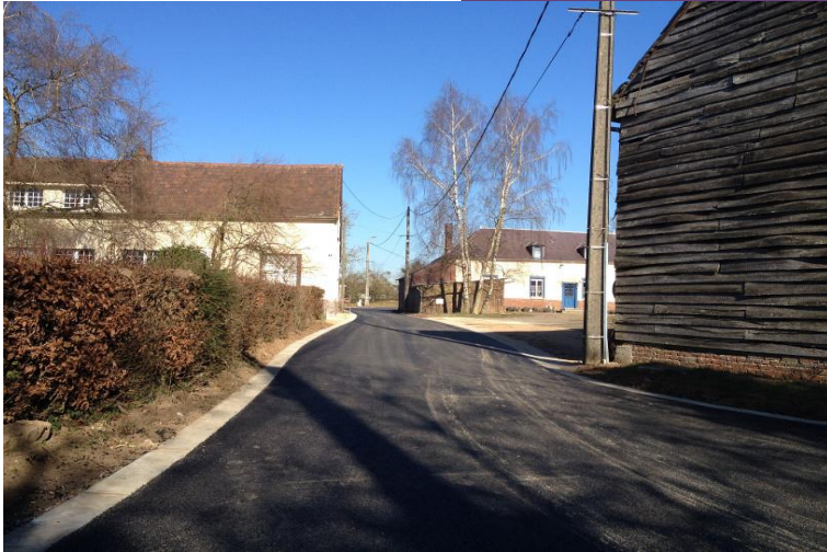
Rue refaite sans bordures
