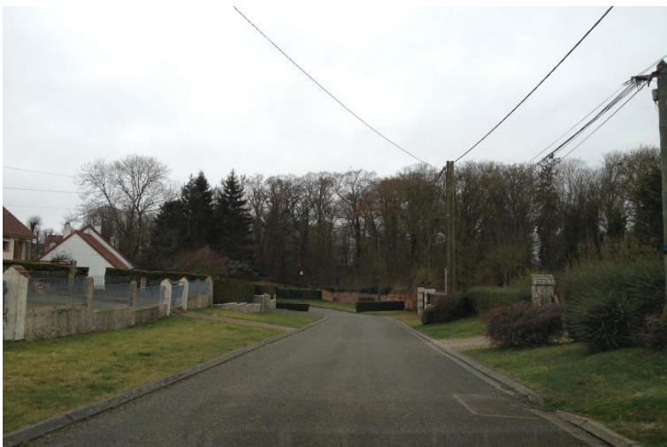
Trottoirs enherbés et bordures
