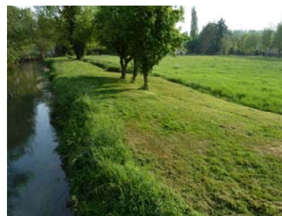
Effet de bourrelet ou de digue le long du bief d'alimentation du moulin
