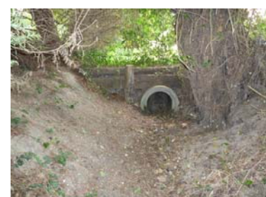
Fossé de la route de Salouel bordant la plaine alluviale et acheminant les eaux vers le fossé bordant la parcelle au nord
