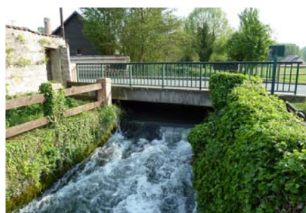
Vannage maintenant un niveau haut dans le bief dominant les parcelles n°63 et 65
