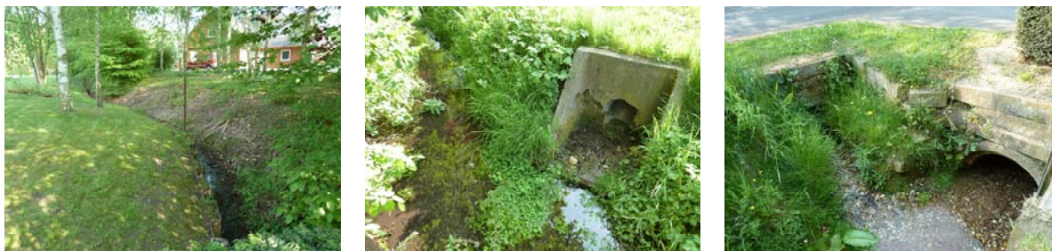
Arrivées de sources, de suintements, et débouché de drainage de nappe dans le ruisseau du "Pré de l'Eglise"
