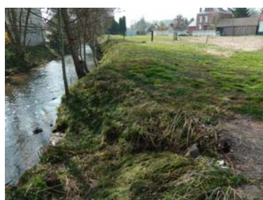
Effet de bourrelet en haut de berge de la parcelle du "Grand Plant" dominant la Selle, préservant la zone de submersion directe
