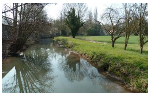
Bief d'alimentation du moulin dont la ligne d'eau est sensiblement supérieure au niveau des parcelles n°63-65
