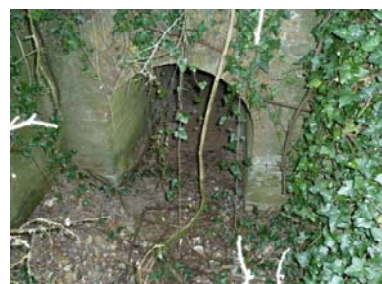
Ouvrage de franchissement du remblai restituant les écoulements en aval
