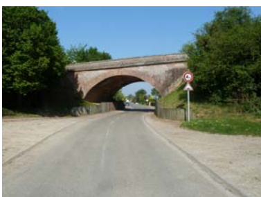
Ancienne voie ferrée en remblai interrompant les ruissellements
