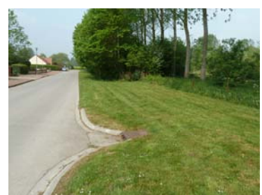
Fossé de la route de Salouel bordant la plaine alluviale et acheminant les eaux vers le fossé bordant la parcelle au nord
